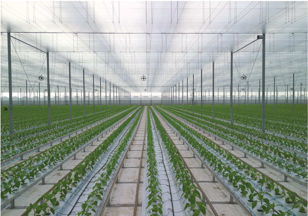
De bestaande scherminstallatie op paprikakwekerij De Bleiswijkse Zoom is eind vorig jaar omgebouwd tot spouwscherm.
